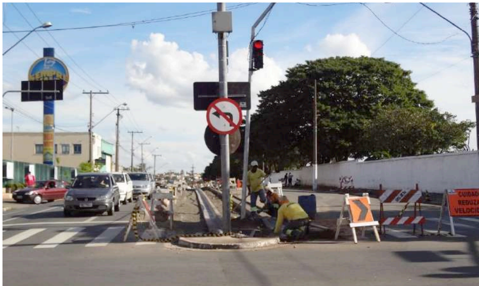
Figura 5 - Obras de redução do canteiro central da Avenida Agostinho Prada, em
