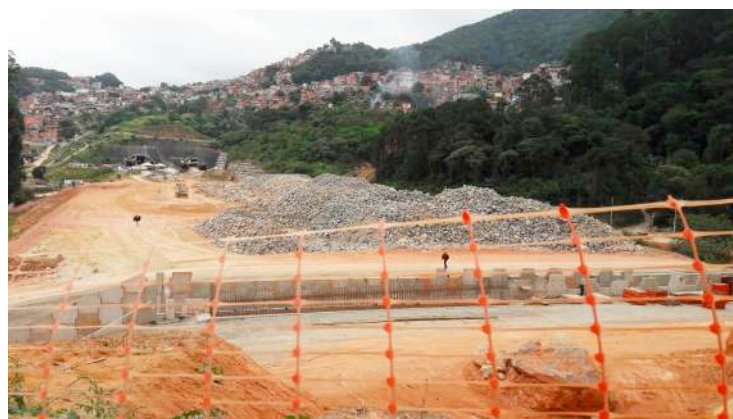
Figura 5: Construção do trecho norte do Rodoanel, e Serra da Cantareira à direita. Arquivo da autora, 2018.
