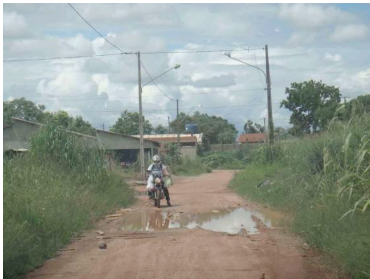
Figura 10: Via com obstrução e sem pavimentação. Foto Priscila Sampaio. 2018
