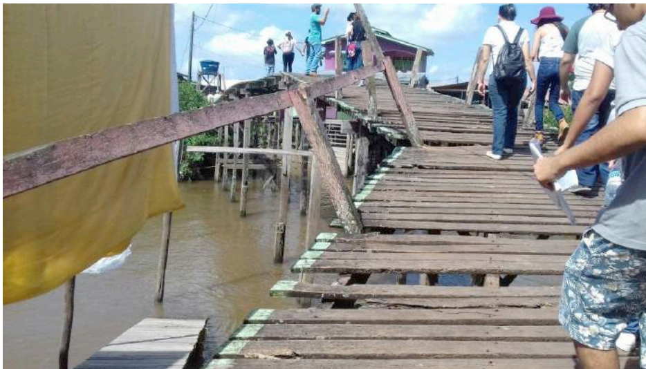
Figura 03: Pontes em mau estado de conservação dificultam a mobilidade no local. Fonte: Autores. 2018.
