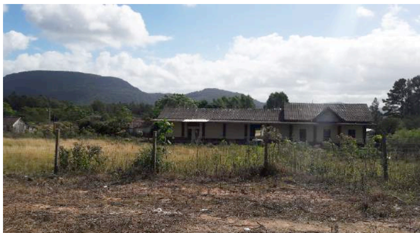
Figura 3. Desuso da edificação e entorno da antiga estação férrea de Camobi. Fonte: Autora. 2015.
