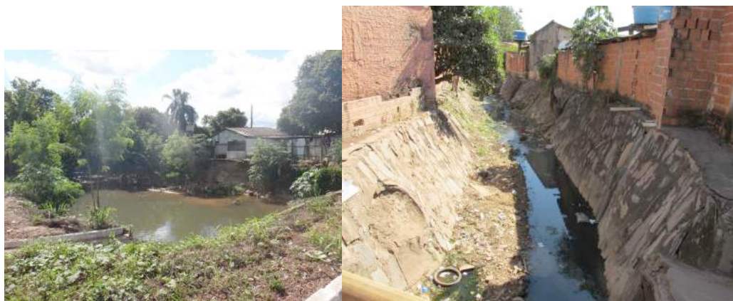
Figura 06: Casas nas margens do córrego. Acervo: Priscila Sampaio. 2018
