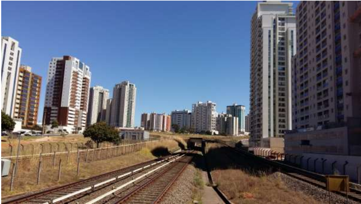
Figura 22: Paredão de edificações margeando a linha do metrô, principal agente da implantação da cidade. Fonte: foto da autora, 2016.
