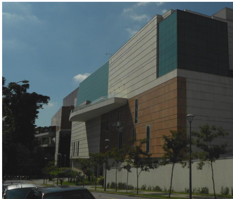
Figura 08: Vista dos fundos do shopping Pátio Batel, com acesso pela Rua Hermes Fontes. Crédito: a autora, 2016.
