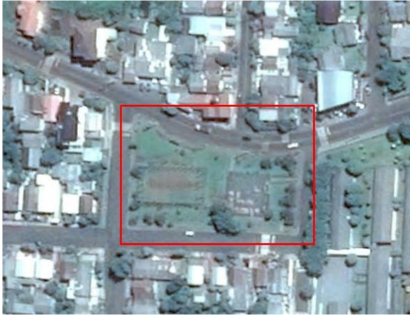
Figura 11: Vista aérea Praça Jk
