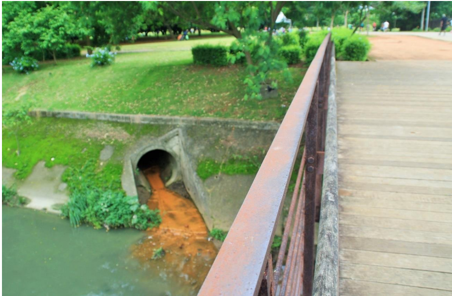
Figura 4 - A foto tirada da ponte sobre do Córrego Carajás. Fonte: foto da autora.
