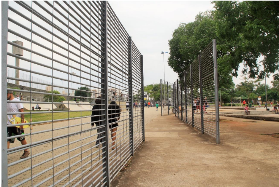
Figura 12 - Cercas de aço auxiliam na divisão das áreas esportiva. Fonte: Foto da autora.
