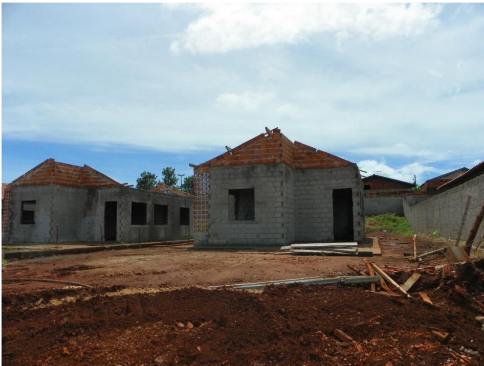
Imagem 02: Processo construtivo do Conjunto Tancredo Neves, Uberaba-MG. Fotografia de Mariana Valicente Moreira, de 26 de fevereiro de 2011.
