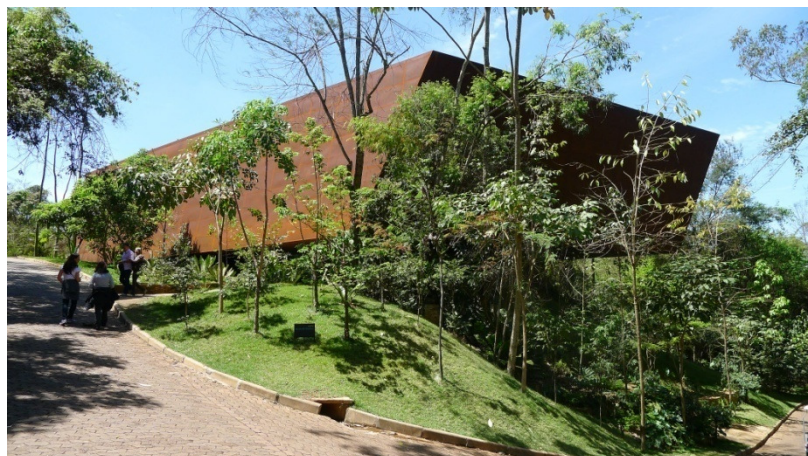
Figura 08- Vista externa da Galeria Miguel Rio Branco. Foto J. R. Merlin
