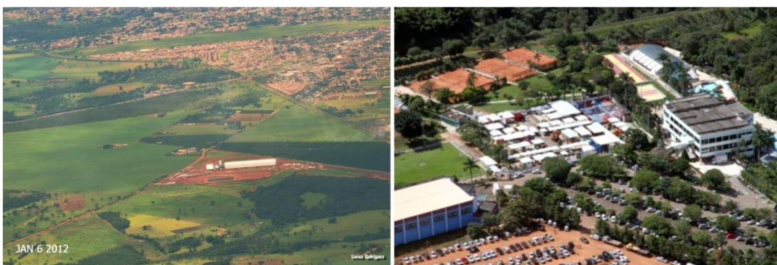
Figura 11: Auréola Periurbana. Terminal de Transbordo da Vale em construção. Foto: L. Rodrigues. Clube Pica-Pau (principal área privada de lazer e realização de grandes eventos da cidade). Foto: H. Vieira.
