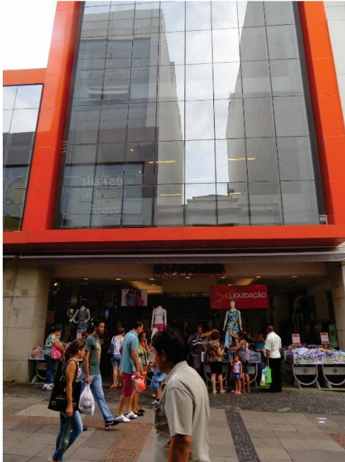
Figura 14: Fachadas totalmente envidraçadas são comuns nesses edifícios. O térreo possui ampla abertura para amostra e disposição das mercadorias de modo a atrair consumidores. Fonte: acervo autores, 2015.
