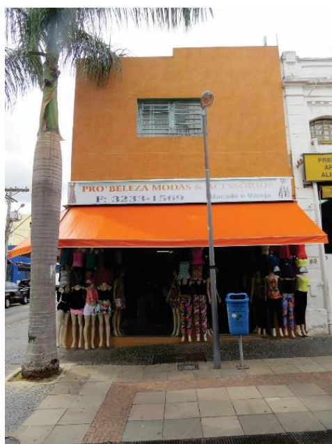
Figura 16: Nota-se a ausência de preocupação com o design da fachada pela total simplificação dos elementos presentes. O toldo realiza o papel da marquise, ausente nessa construção. Fonte: acervo autores, 2015.
