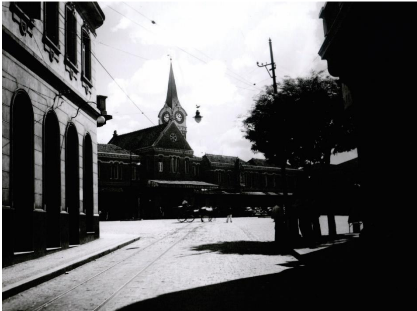
Figura 2: Vista da Estação Ferroviária pela Rua Treze de Maio. Década de 1930. Fonte: Arquivo MIS.
