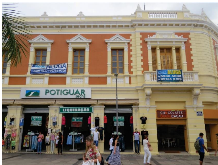
Figura 10: O edifício Roque de Marco ganha destaque na paisagem do Largo da Estação, já no fim da Treze de Maio, pelo seu tamanho e sua ornamentação eclética com algumas características neoclássicas, encontra-se bem preservada, abrigoando no térreo diversas lojas. Fonte: acervo autores, 2015
