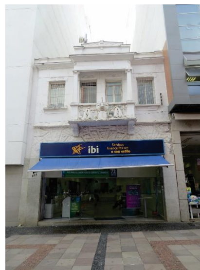
Figura 11: A casa ainda preserva os ornamentos da parte superior. O térreo, assim como nas outras edificações, foi totalmente aberto à rua para se adequar ao novo uso. Nota-se a resistência da edificação em meio a dois prédios modernos. Fonte: acervo autores, 2015.
