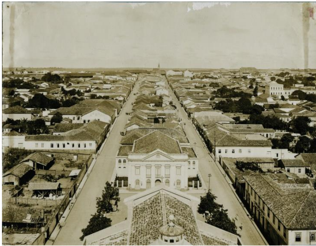
Figura 3: O eixo da Treze de Maio, conectando a Catedral à Estação Ferroviária (ao fundo). 1900. Fonte: Arquivo MIS
