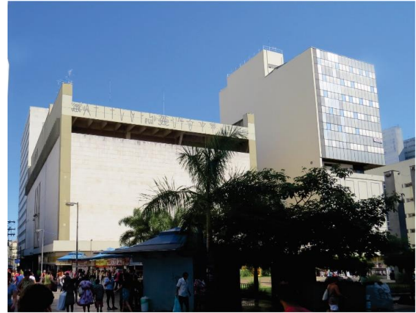
Figura 15: Grande volume de concreto em frente à praça Ruy Barbosa. Fonte: acervo autores, 2015.
