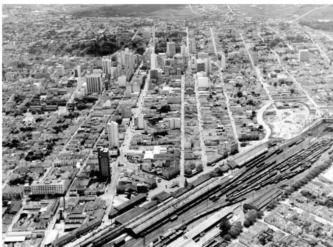
Figura 4: Vista aérea do centro de Campinas, já mais verticalizado. Nota-se o início das obras do Viaduto Cury. Início da década de 1960. Fonte: Arquivo MIS
