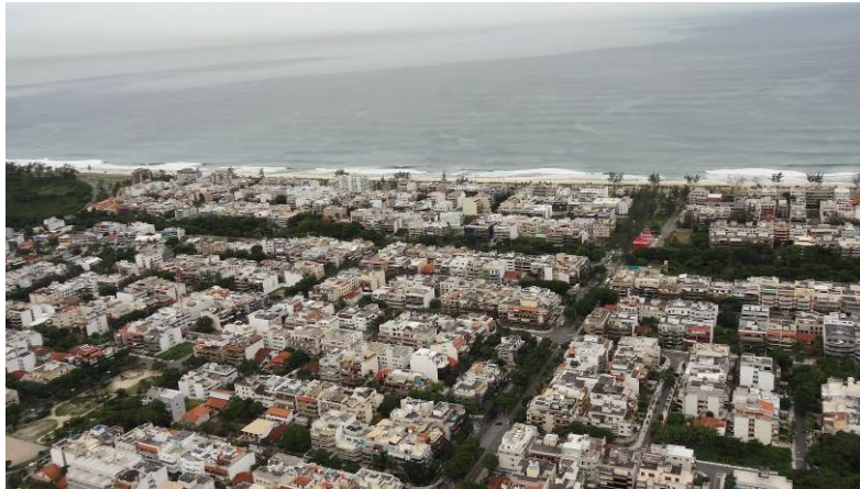
Figura 56. Imagem aérea da UP4 - Recreio dos Bandeirantes - Setor 1 Fonte: Rogério Cardeman, 2013.
